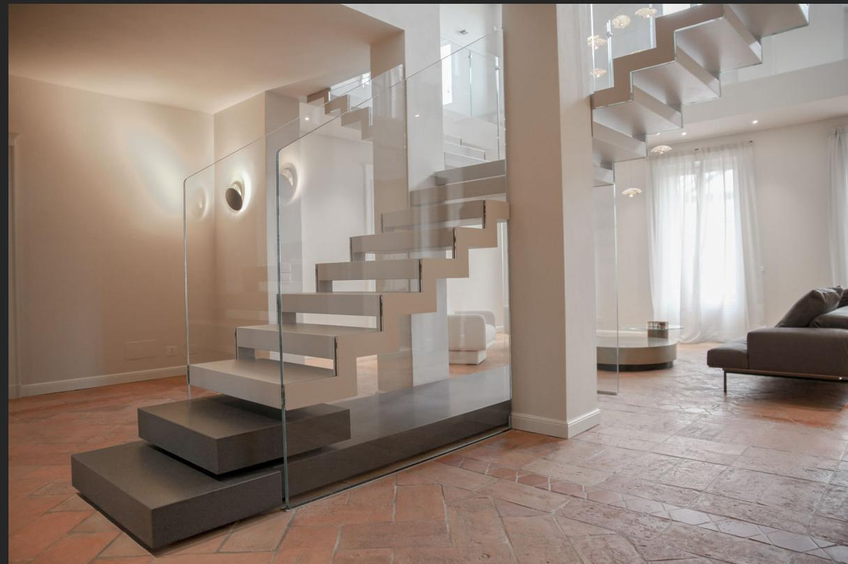
La maturità del design è la caratteristica peculiare del modello FRANZISCA TOP , caratterizzato dalla chiusura a filo struttura di ogni parte ad ottenere un effetto monolitico. La scala è realizzata con alzate aperte, per alleggerire l'armonia del prodotto, e rimanendo tutto completamente smontabile per ispezioni e manutenzione, non esiste in tutta la scala una singola vite visibile.
