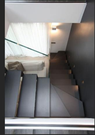
La scala DAVIZ LUX condensa soluzioni moderne proprie degli ambienti URBAN con la raffinatezza delle soluzioni estetiche minimali . Completamente realizzata in acciaio ad alto spessore , viene fornita verniciata con colorazioni ad hoc ad altissima resistenza. I materiali e la finitura sono al top di gamma, così come le soluzioni di assemblaggio. Si noti il parapetto in vetro extra chiaro inserito a sandwich tra profili in metallo pieno , garanzia di massima performance e bellezza.
